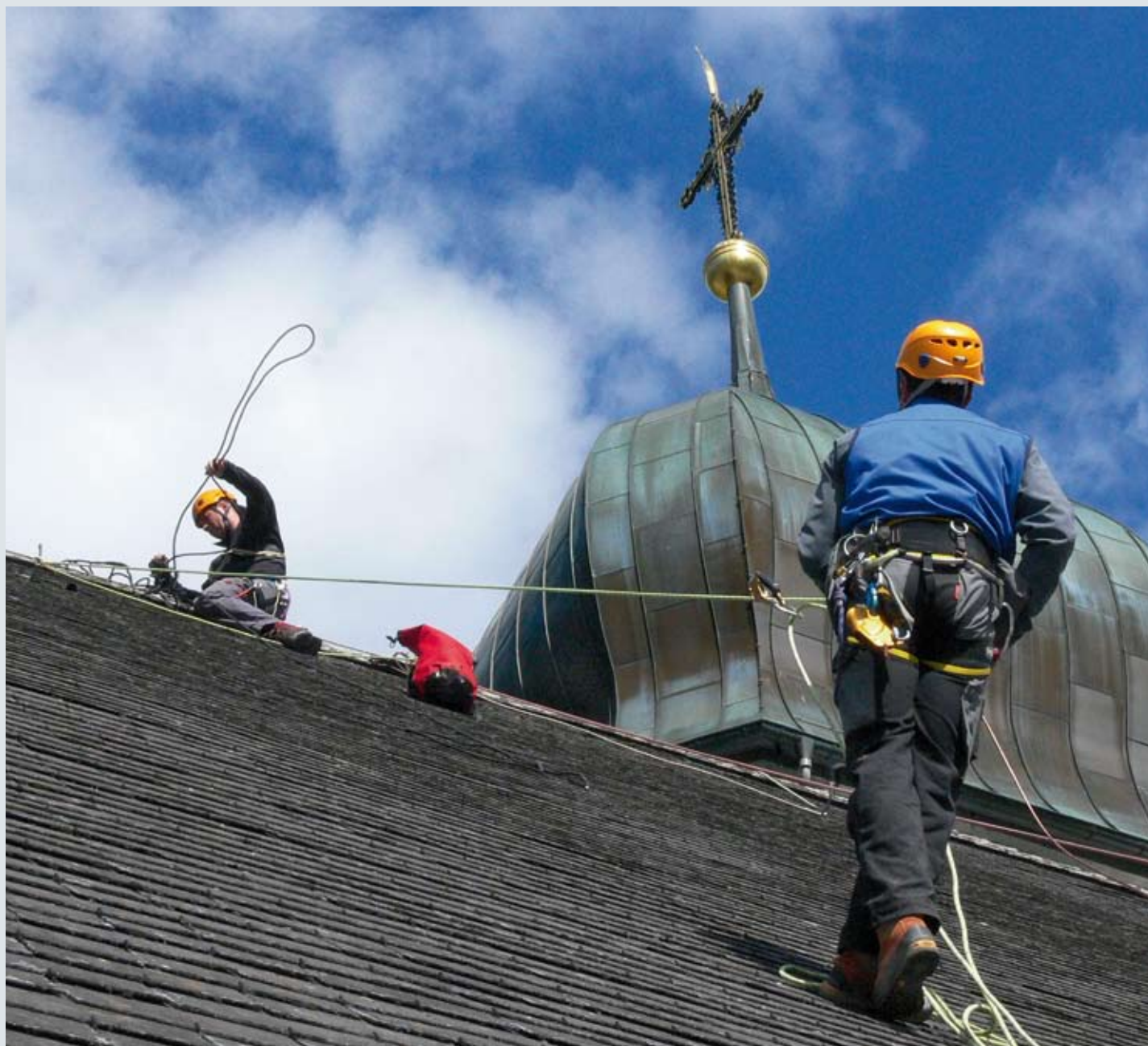
Arbeiten wie die Montage der Blitzschutzanlage bei der Klosterkirche Engelberg wären ohne die Spezialisten nicht möglich gewesen.
